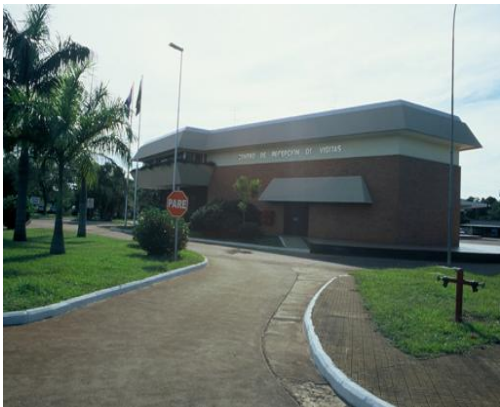
Centro de visitantes de Itaipú. Foto: P.M.T.
