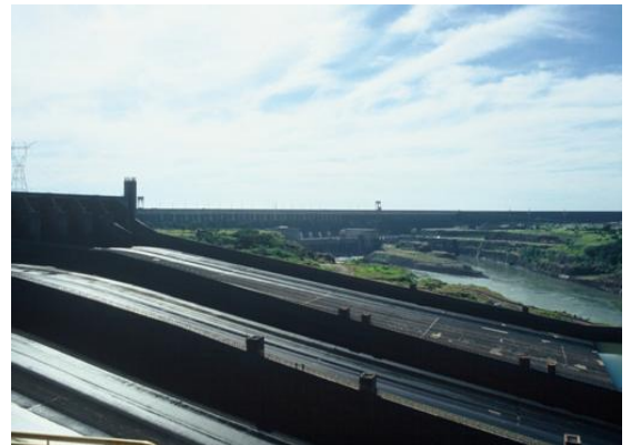
Vertedero de desagüe. Foto: P.M.T.
